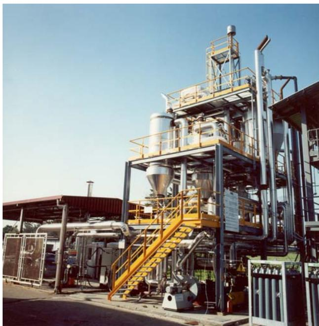
**Figura 1** Impianto sperimentale per la produzione di energia elettrica da biomasse, C.R. ENEA TRISAIA
