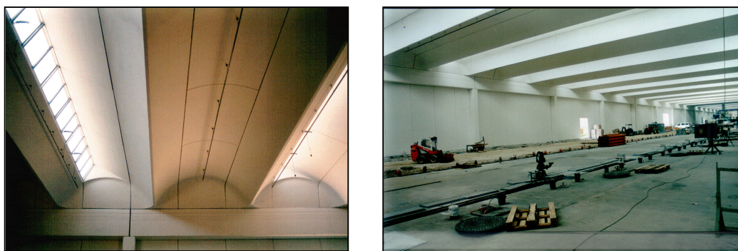
Fig. 3: particolare copertura e vista interna dell' edificio A
