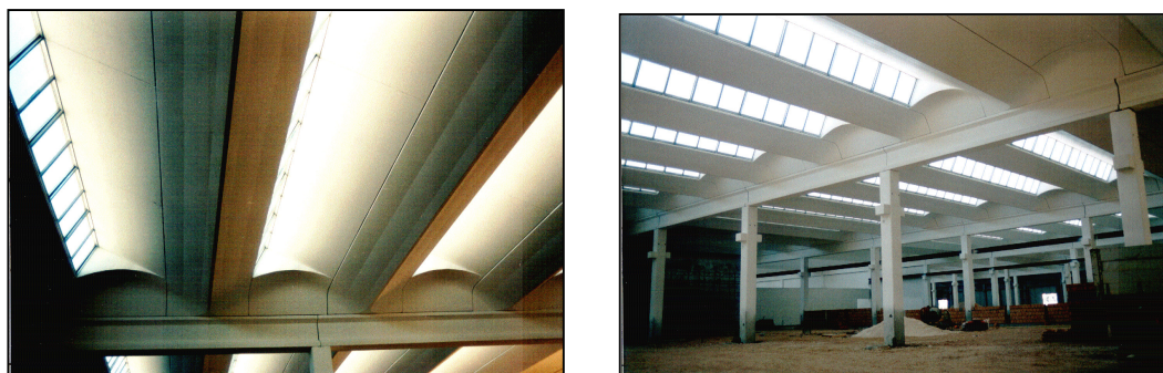
Fig. 4: particolare copertura e vista interna dell' edificio B
