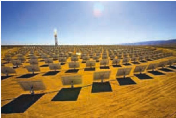
**FIGURA 1 – Siviglia (Spagna).** Negli impianti a torre il campo solare è costituito da specchi piani (eliostati) che inseguono il moto del sole, concentrando i raggi solari su di un ricevitore montato in cima
