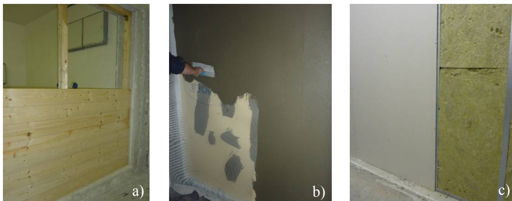
Figura 3 – Fasi di installazione della parete di prova: a) struttura di base in legno, b) rasatura del termocappotto esterno, c) installazione della controparete interna
