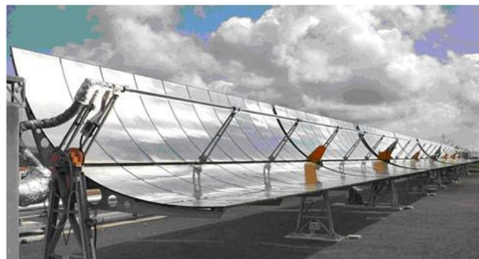
Figura 4 - collettore parabolico lineare.
