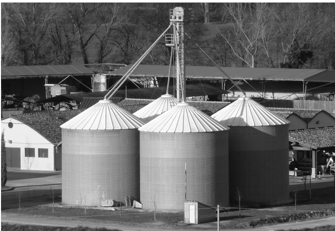
Figura 8: Coperture silos ad elevato albedo ed impianto fotovoltaico
