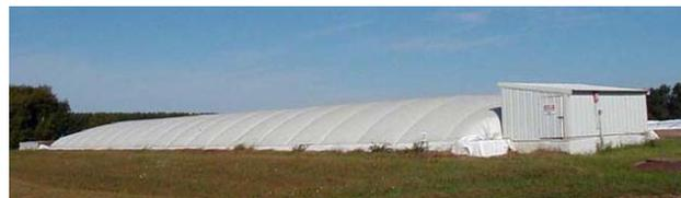
Figura 4: Esempio di digestore PFR
