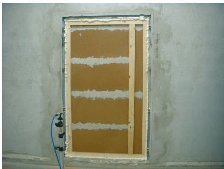
Figura 1 – Installazione dei campioni nella parete ad alto potere fonoisolante
