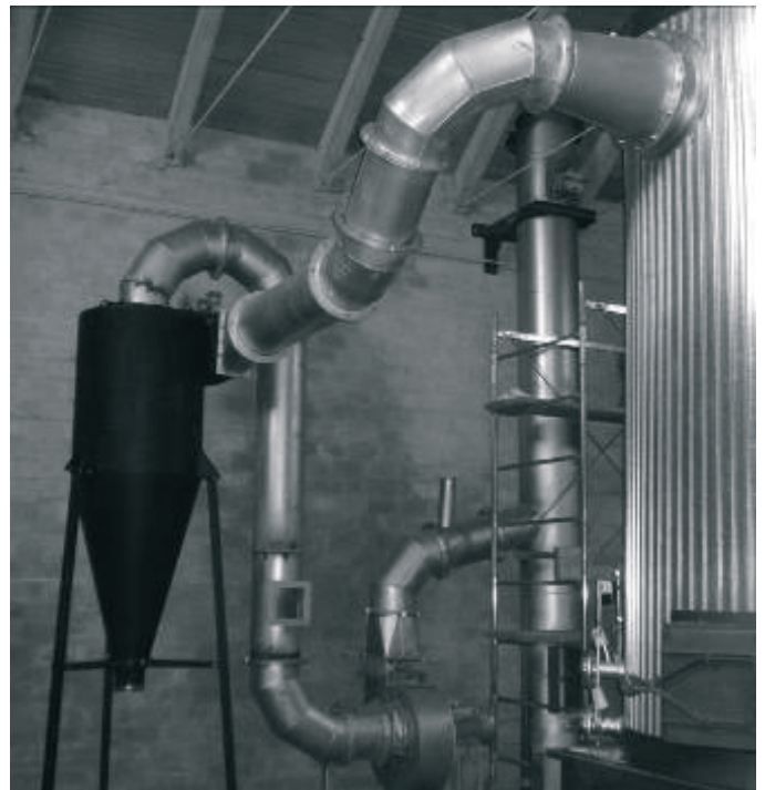
Figura 6: sezione trattamento dei fumi di scarico della caldaia a cippato
