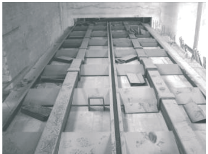
Figura 3: silos con rastrelliera su solaio rialzato
