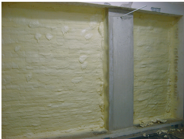
Figura 1: campione in muratura, sezione in corrispondenza della colonna in cemento e dettagli di posa in opera
