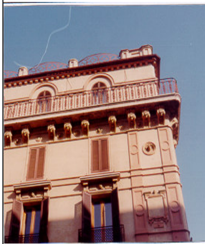
PARAPETTI PRESENTI SUL LATO OVEST
