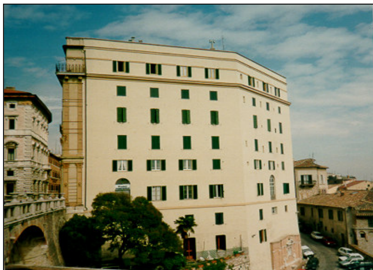
FRONTE DEL FABBRICATO ESPOSTO A SUD CHE EVIDENZIA LA PRESENZA DI CORDOLI PERIMETRALI
