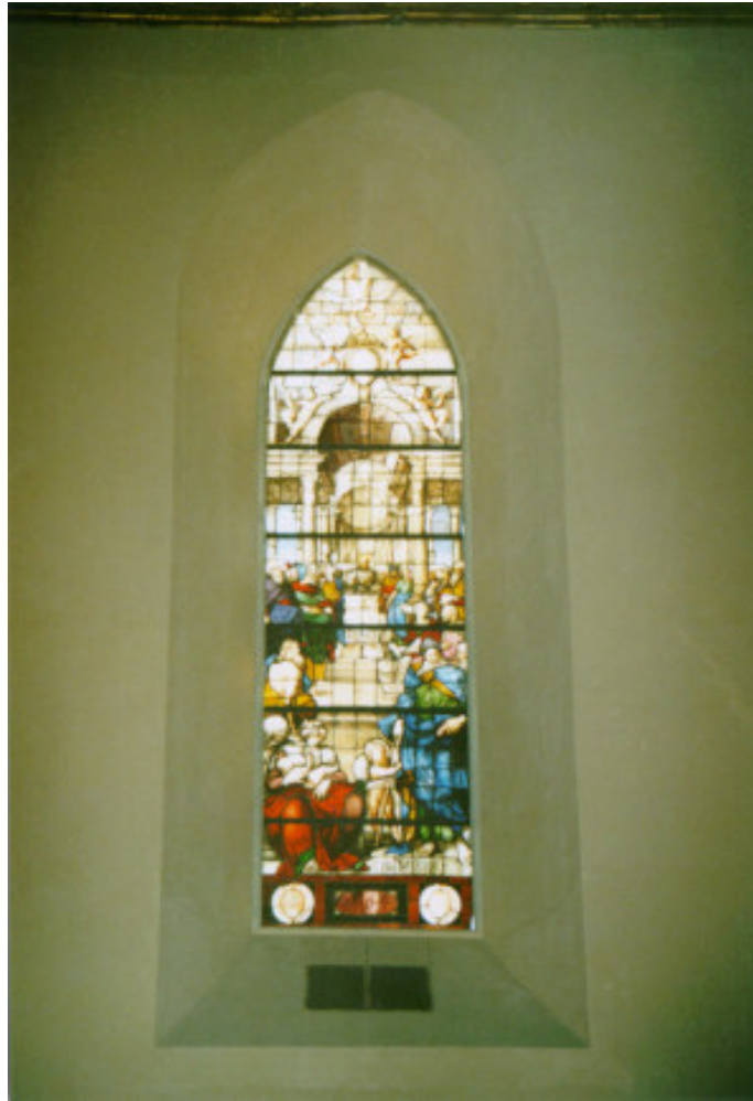
Fig. 1: la vetrata di Arrigo Fiammingo; nella svasatura inferiore della monofora è visibile la griglia di aspirazione dell'impianto di termoventilazione.
